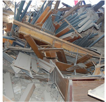
Blick vom Kirchenschiff auf die Trümmer; 22. Februar 2016
