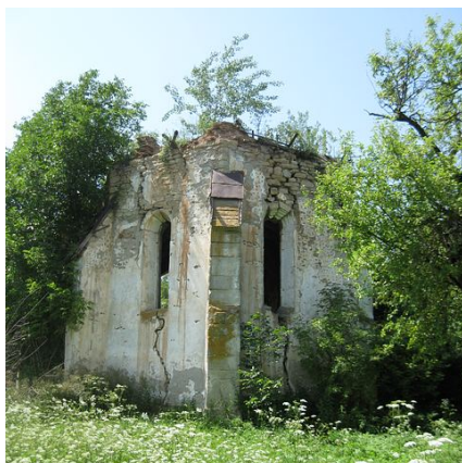
Chorraum von außen
