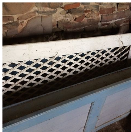
Seitenwand in einem der Wehrtürme
