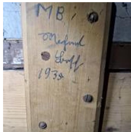
Inskription an der Balganlage
