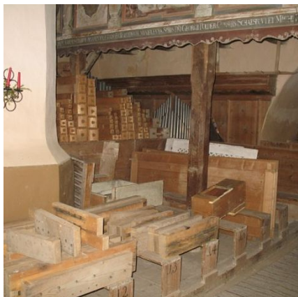
Während der Reparatur 2009
