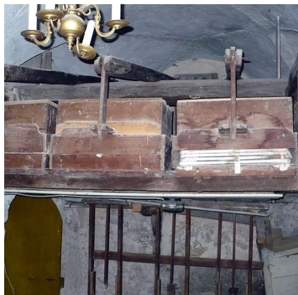
Balganlage in Sakristei
