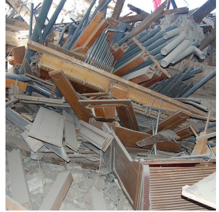
Blick vom Kirchenschiff auf die Trümmer; 22. Februar 2016
