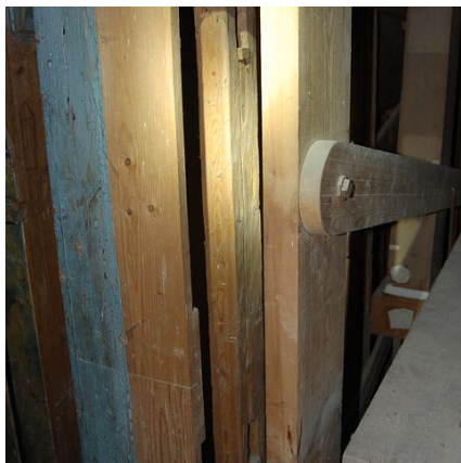
Detail der jetzigen Balganlage mit Spuren der alten Keilbalganlage links am Gehäuse Pfosten und hinten am Kanal
