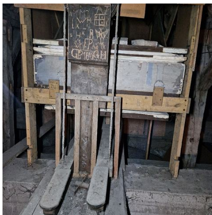
Inskription an der Tretanlage
