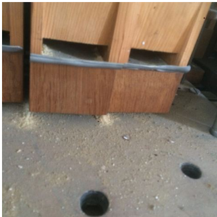
Holzwurm arbeitet; 13.1.2020 die beiden Löcher vorne stammen von den fehlenden grossen Prospektpfeifen.
