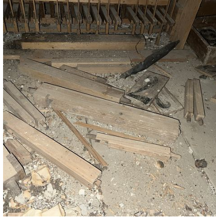
Die hinten an der Orgel fehlenden Subbasspfeifen liegen im Orgleinnern am Boden
