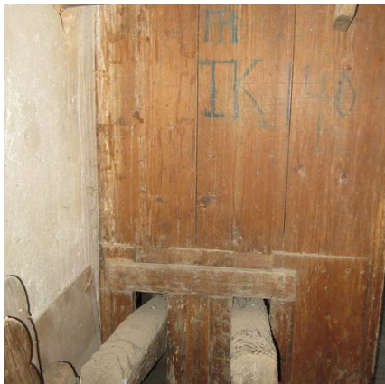
Fusstritte der Balganlage im Turmzimmer. Nicht angekoppelt; nicht restauriert
