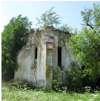
Chorraum von außen
