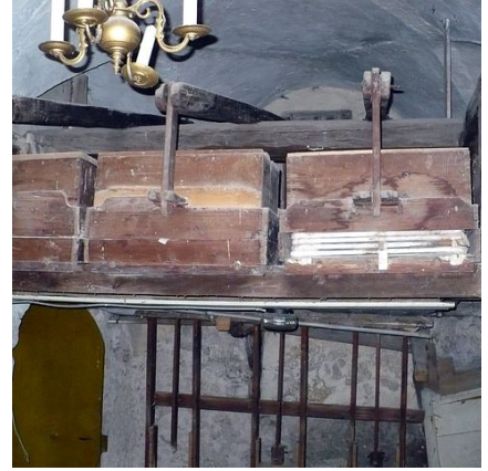
Balganlage in Sakristei
